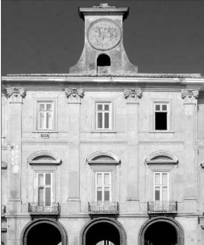
La provincia di Napoli ha acquistato 18 opere di un privato napoletano per incrementare la sua collezione di quadri dell'800. I quadri troveranno una sistemazione definitiva nella reggia di Portici, recentemente restaurata e riaperta.
