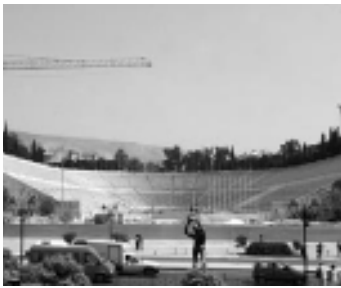
Atene 2004 Un cantiere dei giochi olimpici di Atene del 2004. E' lo stadio di marmo Panathenian, dove si svolgeranno le gare di tiro con l'arco e la finale della maratona.
